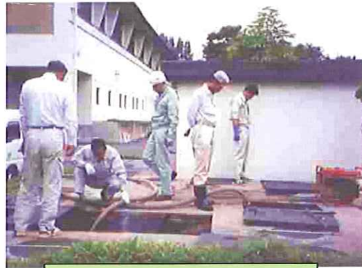
从充气槽 向沉淀槽 运送活性水
